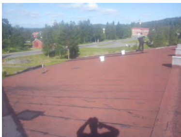
Obehandlat, gammalt papptak med småsprickor...
